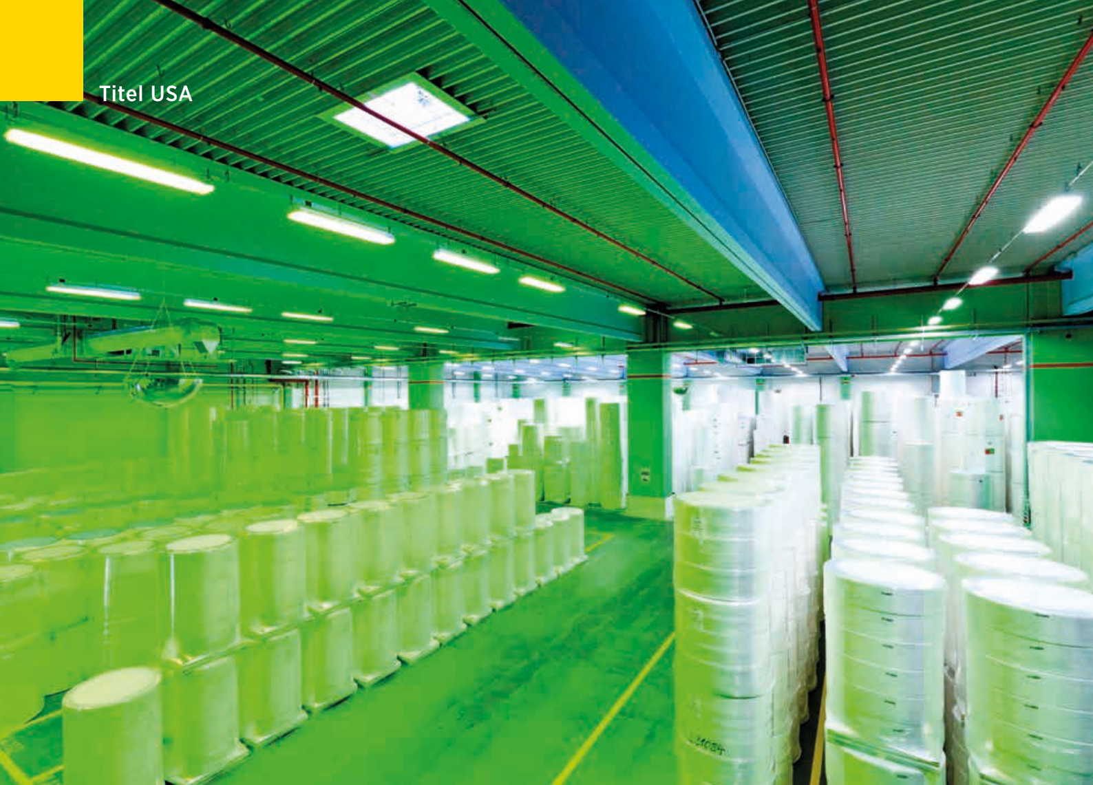
Ab in die USA: In Perry will der Vliesstoffhersteller Sandler 2016 ein neues Werk eröffnen.
